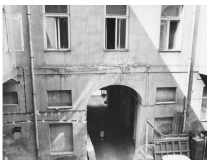
Nyugati szárny udvari homlokzata (forrás: Bp. V., Szép utca 6. Műemléki Tudományos Dokumentáció -2011.)
