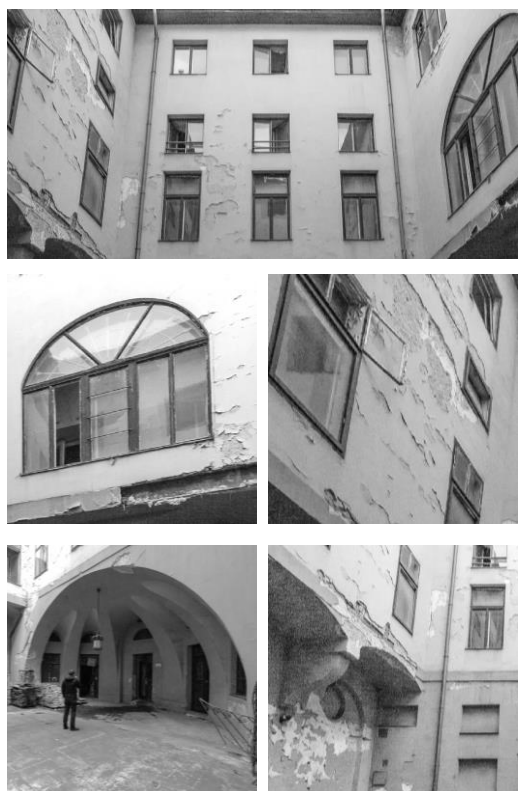
Belső udvari homlokzatok jelenlegi állapota
